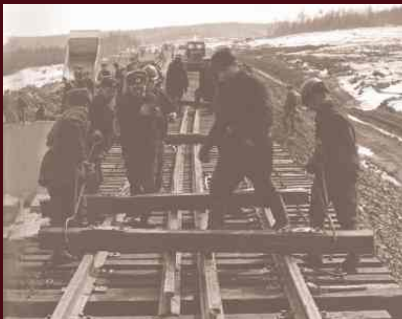
На укладке верхнего строения пути пос. Дипкун, 1978 г.
