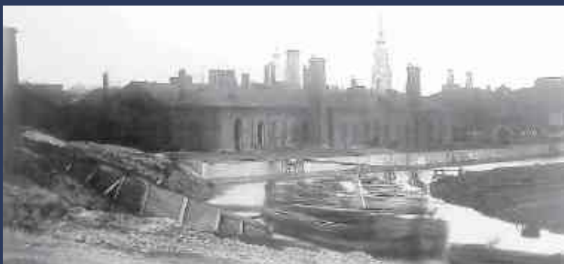
Общий вид здания железоделательного (броневого) отдела постройки 1862—1866 гг.
