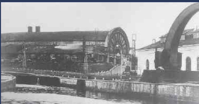
Справа — фрагмент здания железоделательного (броневого) отдела постройки 1862—1866 гг.; перед ним — кран грузоподъёмностью 50 т для погрузки броневых плит на баржи. В центре — здание нового бронепрокатного цеха постройки 1876—1879 гг.
