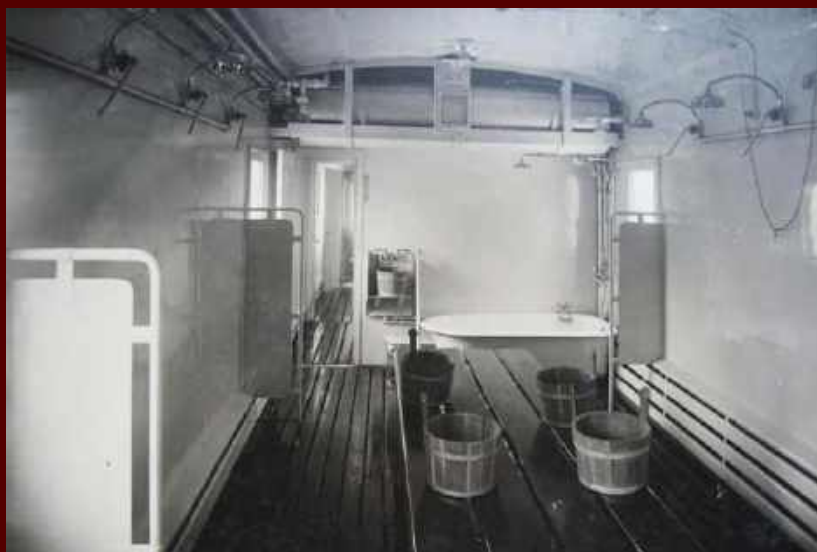
Оборудование вагона банно-прачечного дезинфекционного поезда периода Великой Отечественной войны Из фондов ВММ МО РФ
