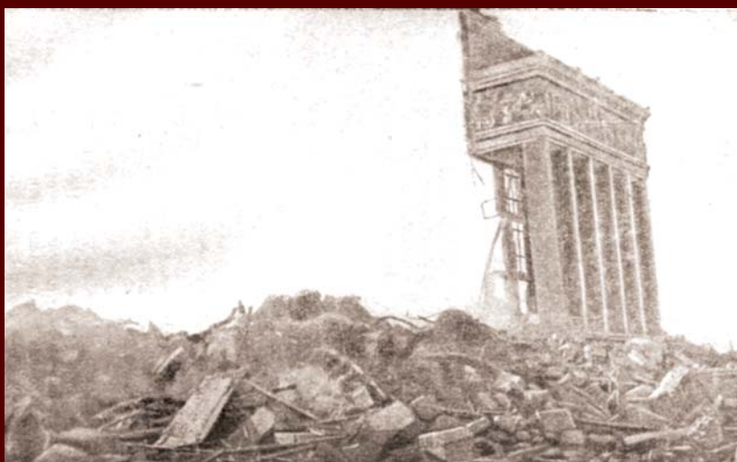
Руины здания обкома ВКП(б) в Воронеже
