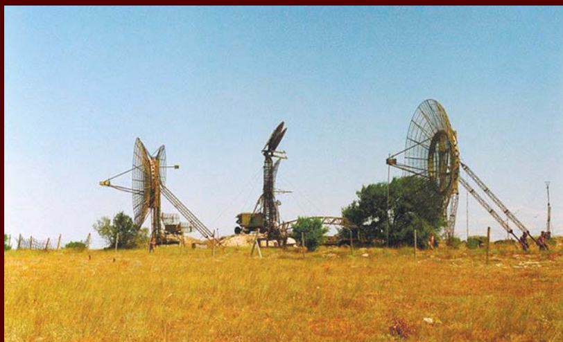
Станция тропосферной связи Р-420
