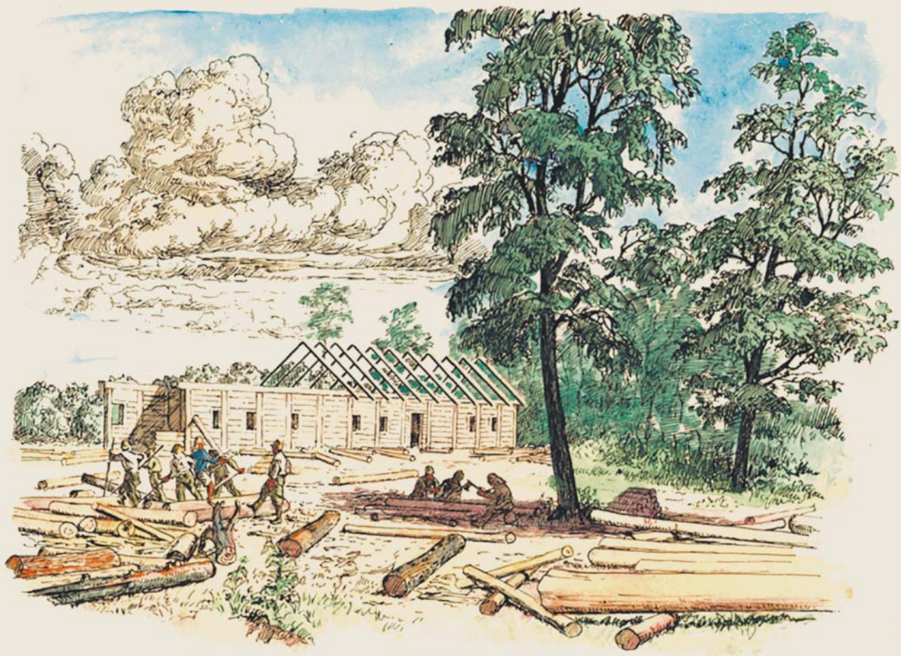
Рисунок японского военнопленного «Строительство казармы»
