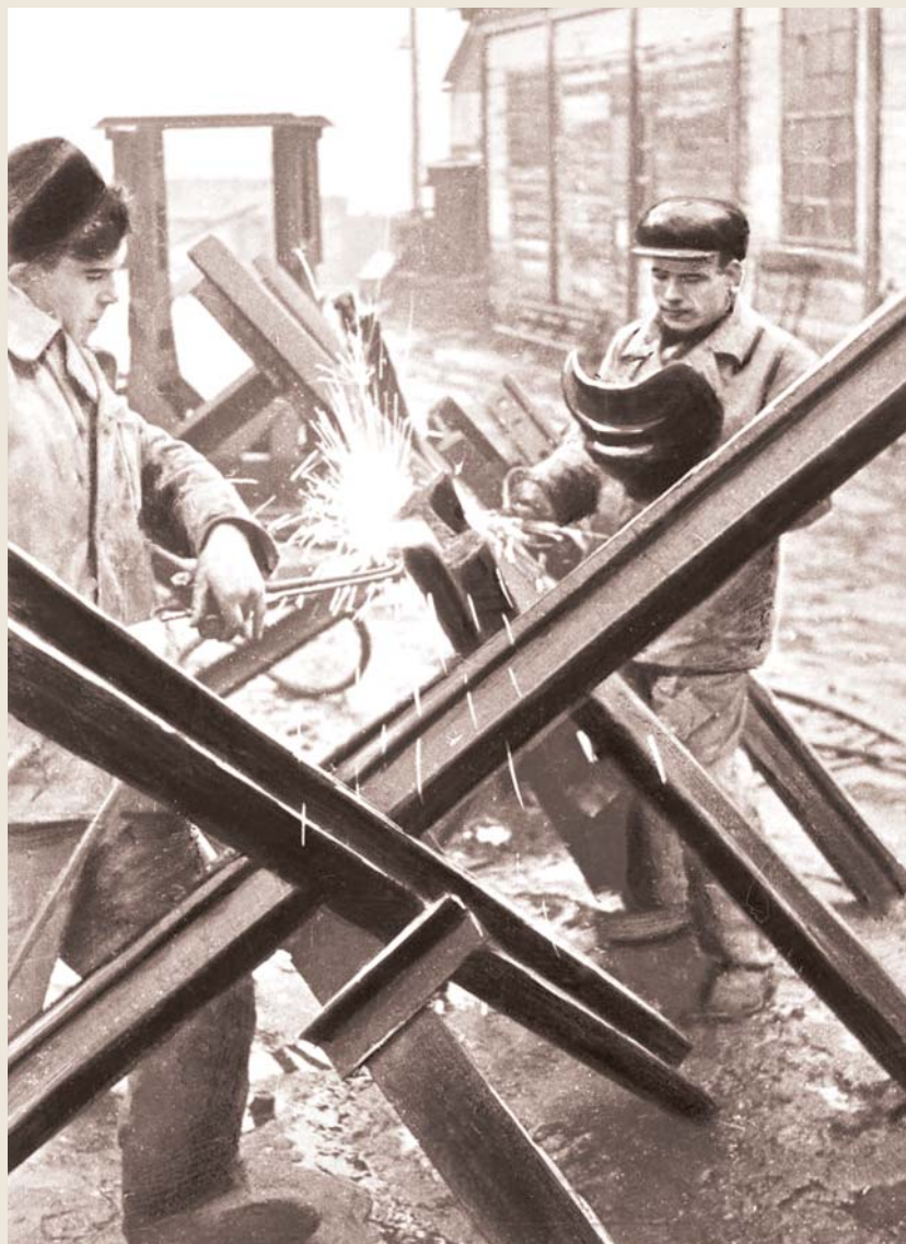
Сварка противотанковых ежей Москва, октябрь 1941 г. Фото Б.Е. Вдовенко
