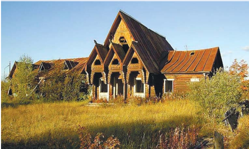
Здание Дома пилотов, сгоревшее в 2016 г.
