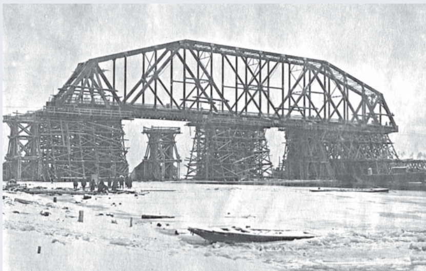
Перекатка пролётного судоходного строения через промежуточную опору зимой 1941/42 г. Музей завода № 50
