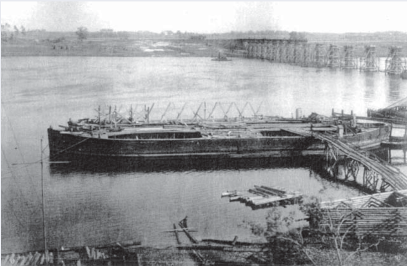
Установка ферм «ГАУ» на барже плавучей опоры. На переднем плане — смонтированный из брёвен ледорез Архив завода № 50
