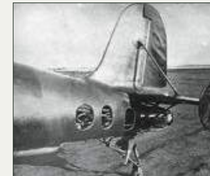
Хвостовая часть самолёта БИ-1 с реактивным двигателем. Фото 1942 г.
