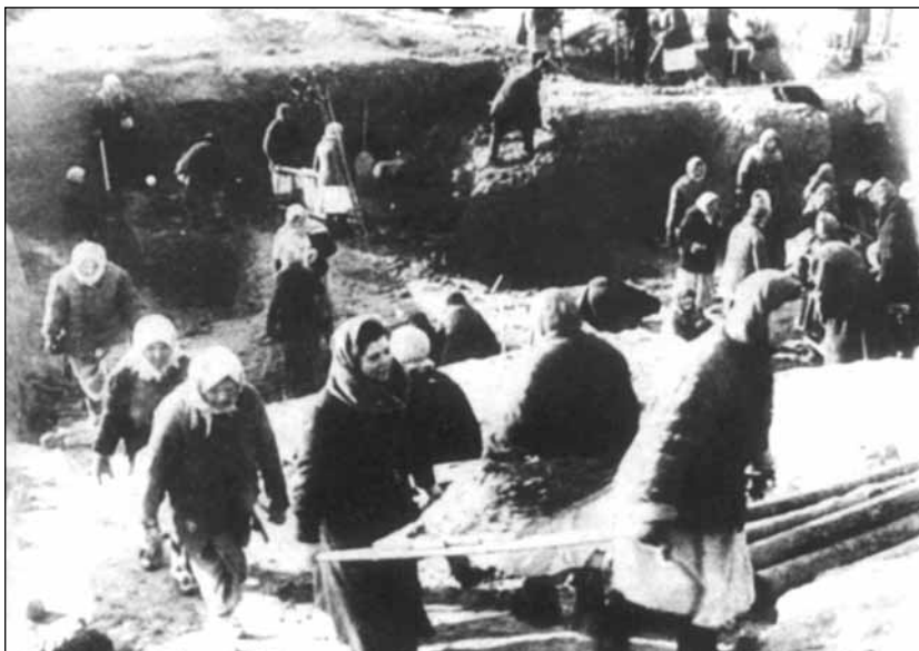
Астраханцы на строительстве оборонительного обвода Из фотофонда Государственного архива Астраханской области
